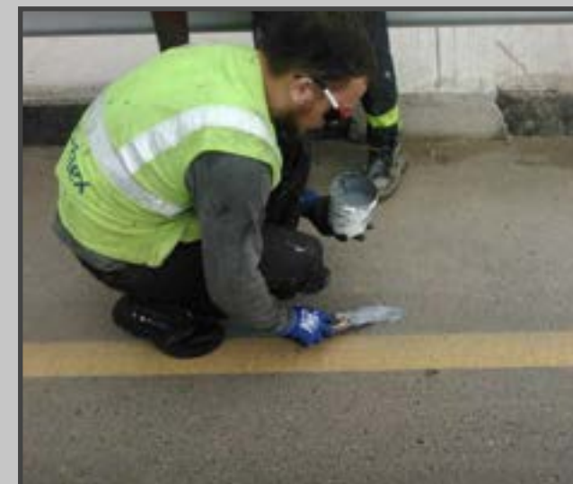
Línea de borde de pavimento
