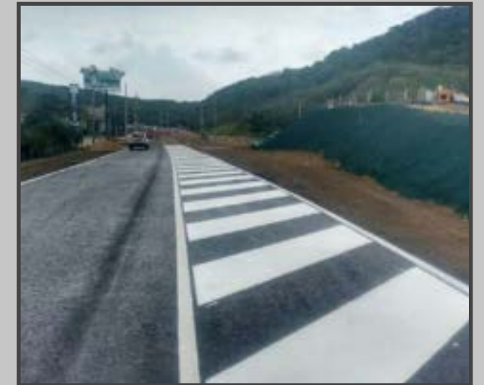
Líneas de transición por reducción de carriles
