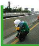
Instalación de tachas reflectivas
