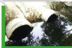
Limpieza de alcantarilla
