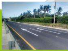
Señalización Horizontal - Flechas de sentido de circulación
