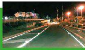
Señalización horizontal - tachas reflectivas
