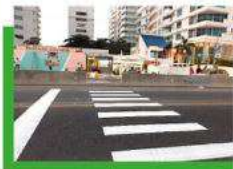
Señalización horizontal - paso peatonal
