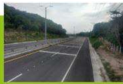
Líneas reductoras de velocidad
