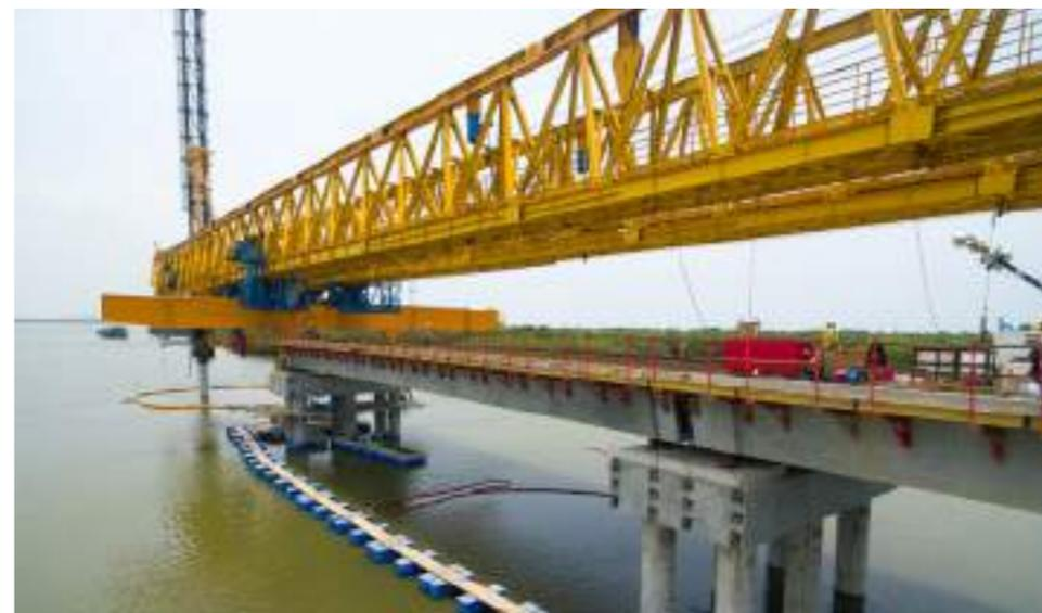
Ilustración 58. Armado de la losa del tablero
