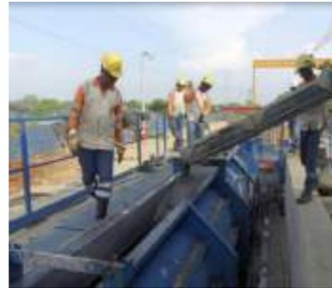
Ilustración 36. Vaciado del concreto
