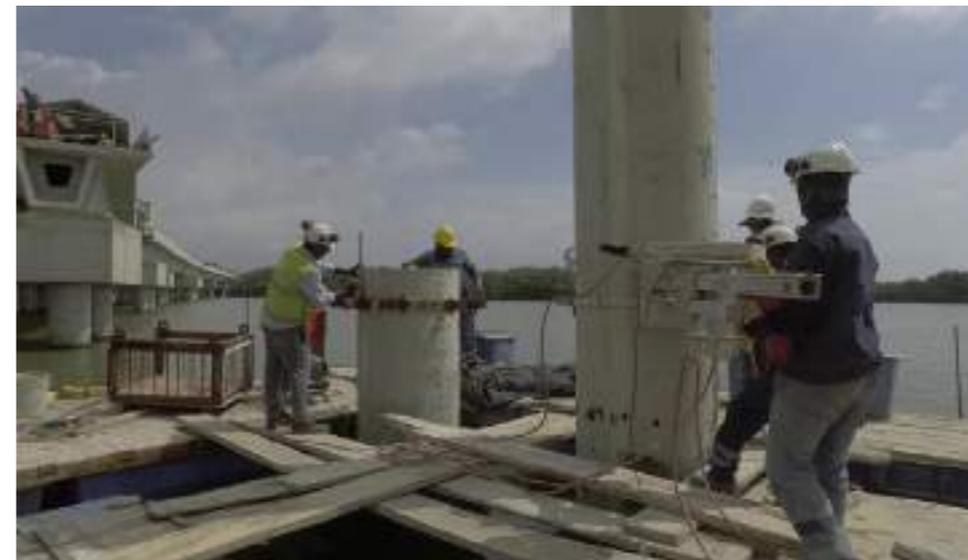
Ilustración 52. Proceso de corte de pilote con hilo diamantado
