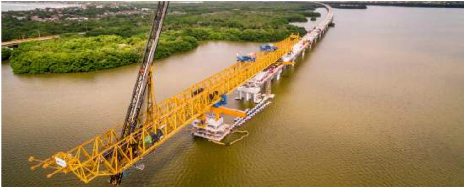
Ilustración 49. Posicionamiento del martillo con viga lanzadora
