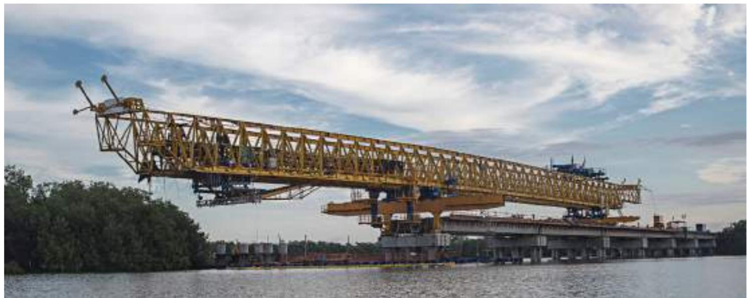
Ilustración 63. Viga Lanzadora
