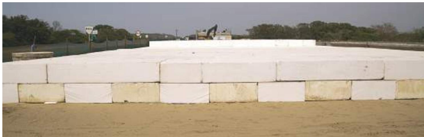
Ilustración 14. Uso de EPS para la conformación de terraplenes
