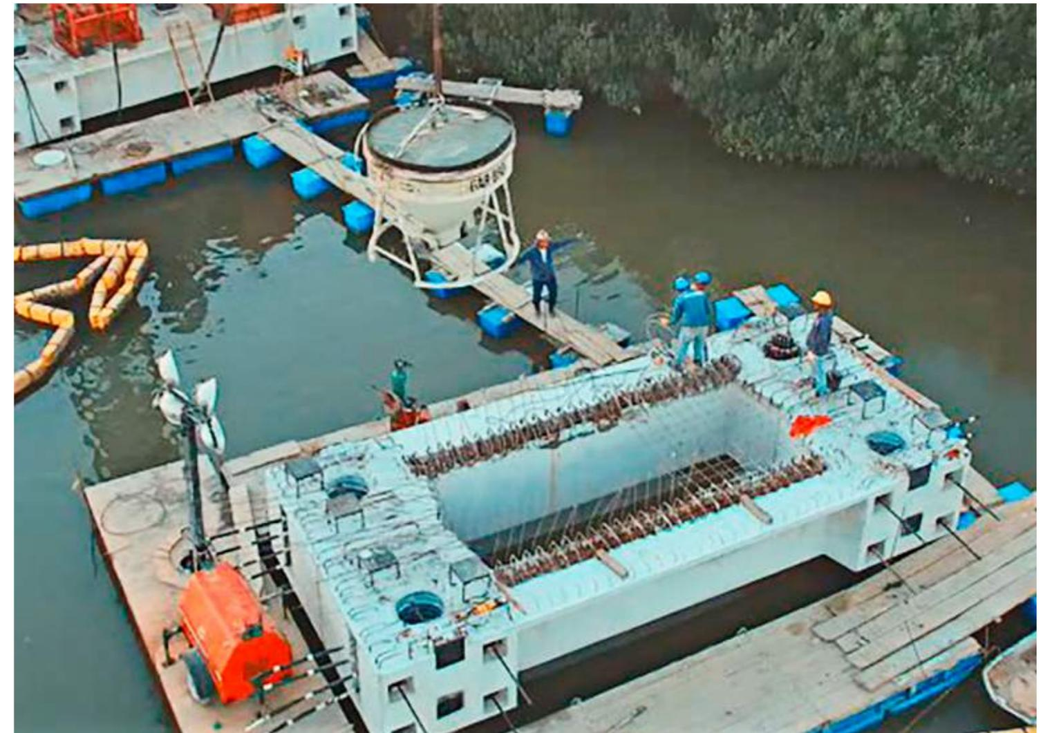
*Ilustración 55. Proceso de fundida del tapón de acople entre el cabezal y el pilote del Retorno de los cabezales con los pilotes del Viaducto*
