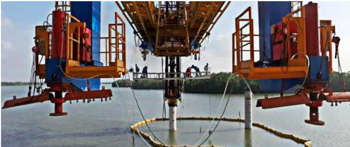
Ilustración 50. Hincado de pilotes en vista frontal
