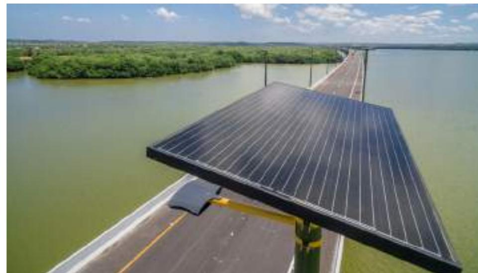
Ilustración 69. Panel solar monocristalino
