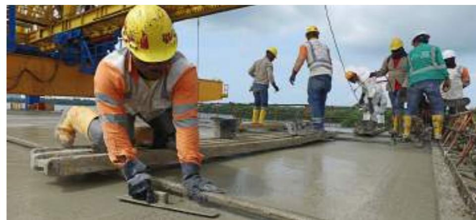
Ilustración 59. Fundida de la losa del tablero
