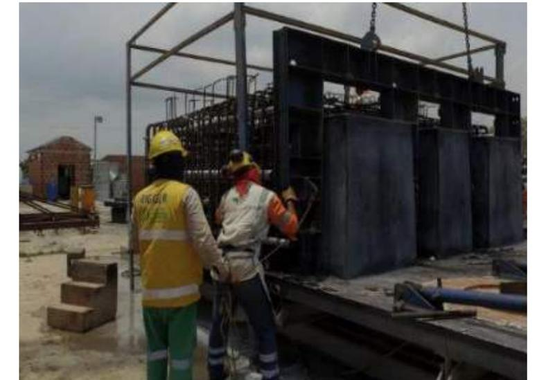
Ilustración 41. Instalación del molde
