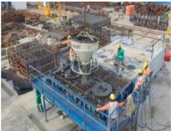
Ilustración 42. Vaciado de concreto
