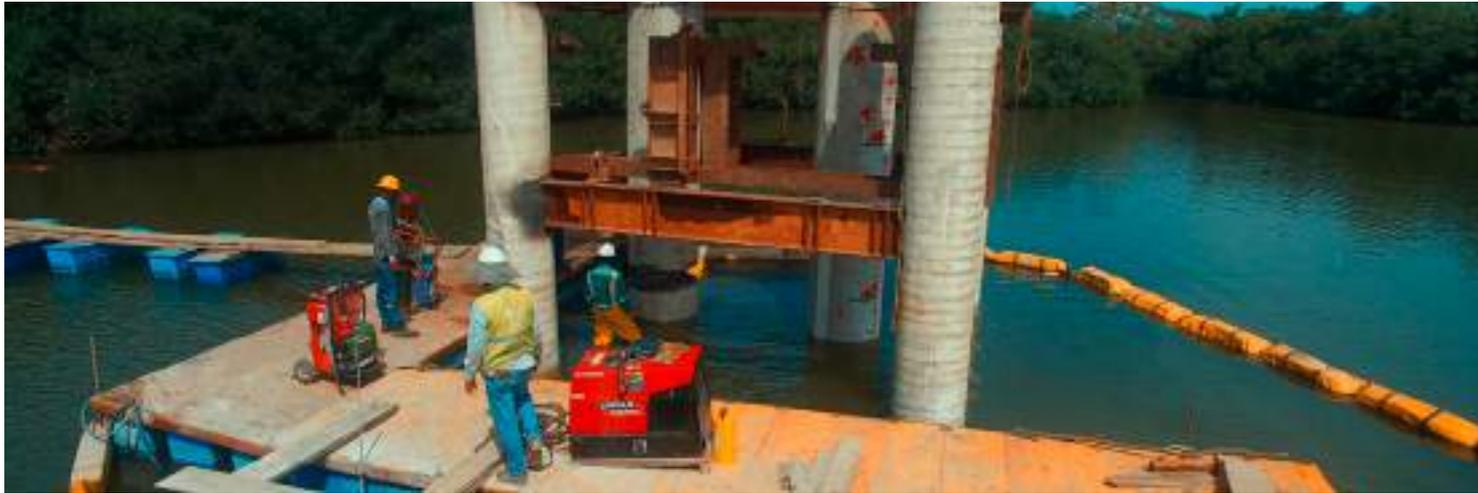
*Ilustración 53. Acople de pilote mediante junta mecánica*
