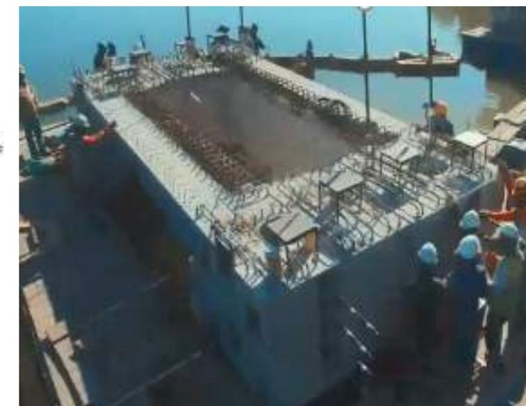
Ilustración 25. Sección típica cabezal tipo post-tensado del retorno compuesto por dos secciones.
