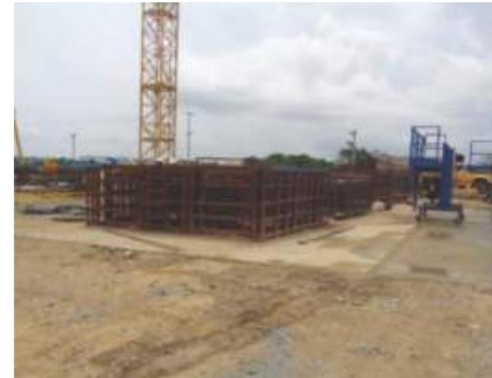
Ilustración 40. Armado de refuerzo
