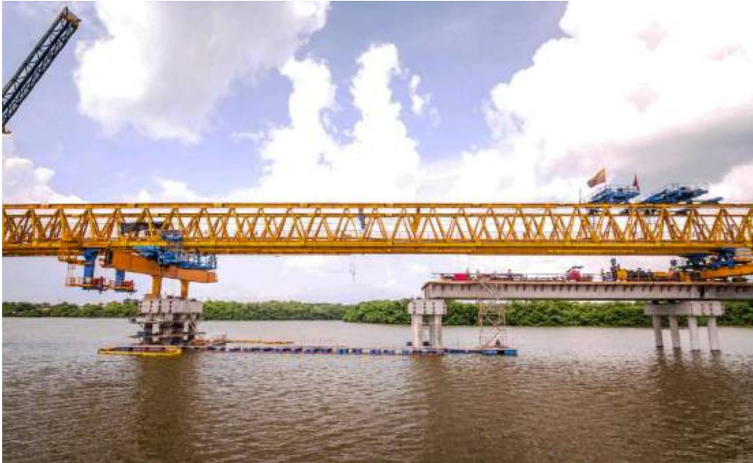
Ilustración 60. Construcción de vanos Gran Viaducto
