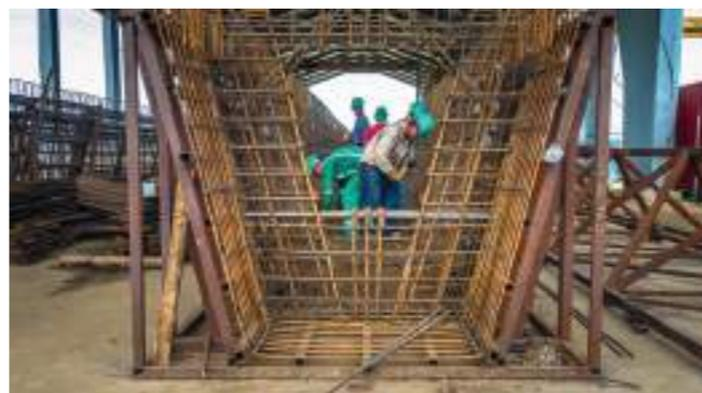
Ilustración 44. Armado del refuerzo
