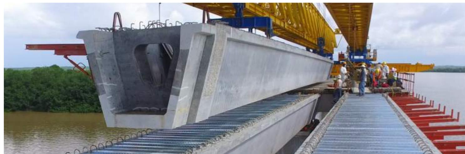
Ilustración 57. Instalación de las vigas
