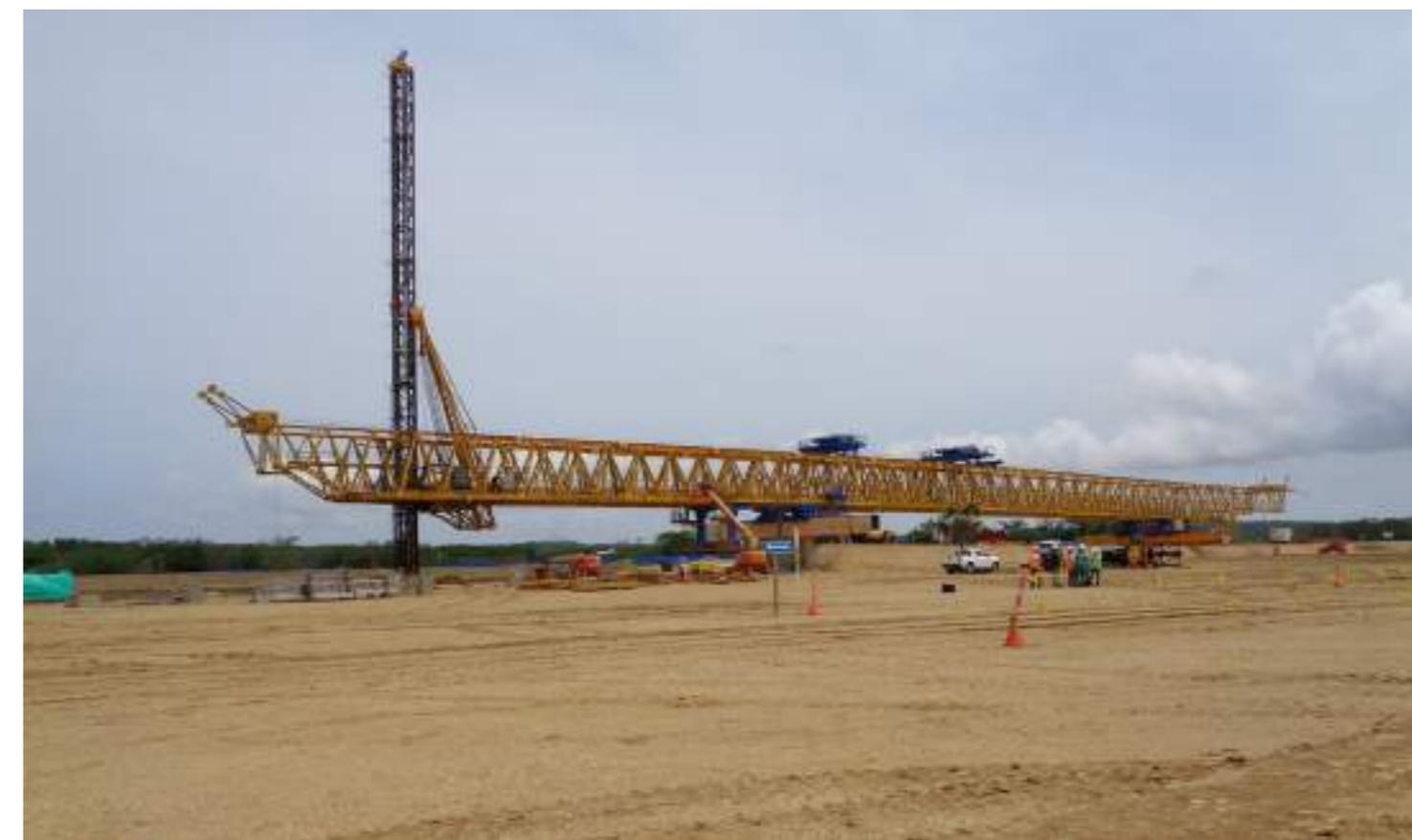
Ilustración 48. Posicionamiento vertical del martillo (imagen en tierra)
