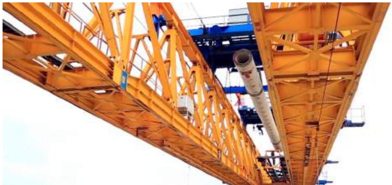
Ilustración 62. Malacate (Winch) de la viga lanzadora
