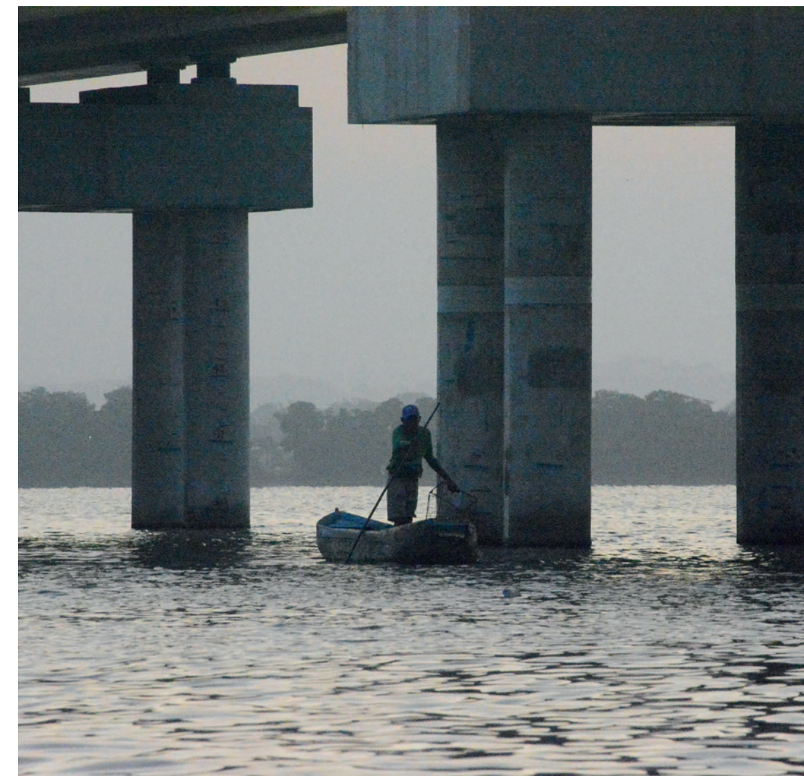
Figura 9. Pescador artesanal de la Ciénaga de la Virgen, cerca de las columnas de soporte, diseñadas para permitir el flujo hídrico natural, bajo la infraestructura del Viaducto.
