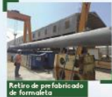
Retiro de prefabricado de formaleta
